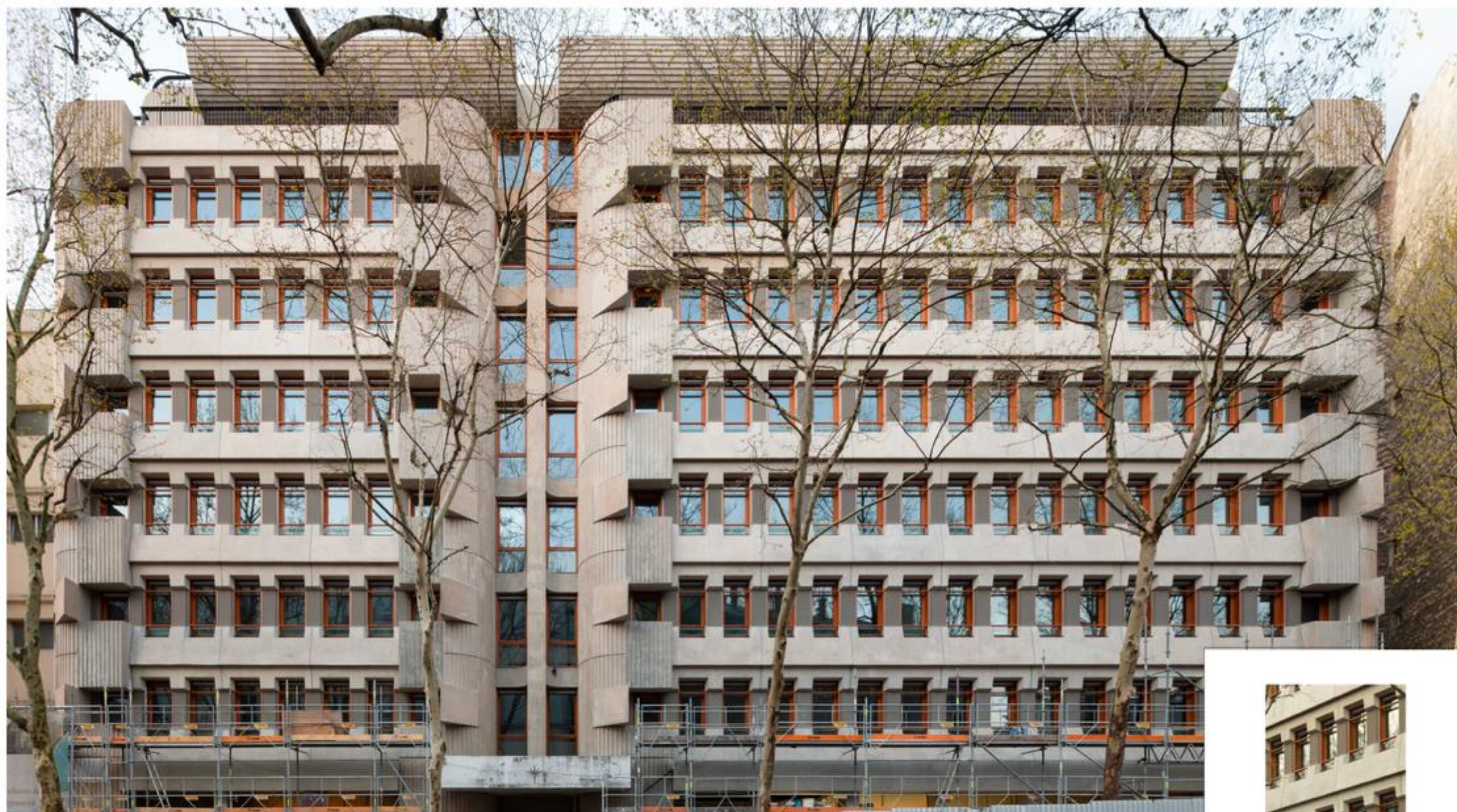
58-66 MOUZAÏA Transformation bureaux → logements
