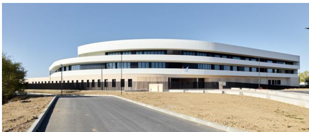
Collège 600 Guillermy (31) Gain de 34 Tonnes de CO 2 /an Vs solution Gaz
