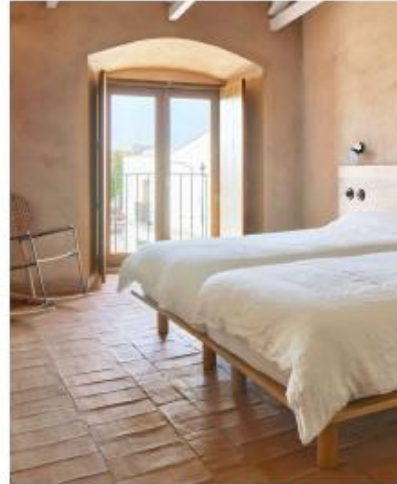
conservation des tomettes et carreaux de terre cuite anciennes
