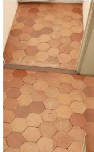
raccord de sol entre matériaux, anciens pieds de cloisons comblés par mortier coloré
