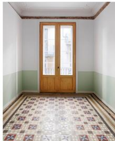
conservation des carreaux de ciment ancien
