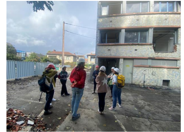
Visite d'opération lors de la formation déconstruction sélective du 28-29 septembre 2022
