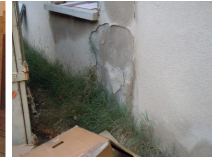
Traces d'humidité et enduit extérieur dégradé
