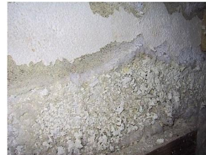
Présence de Salpêtre (Photo : humidites.fr)
