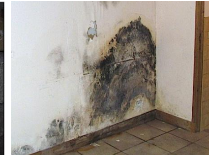
Présence de moisissures (Photo : prix-immobilier.info)
