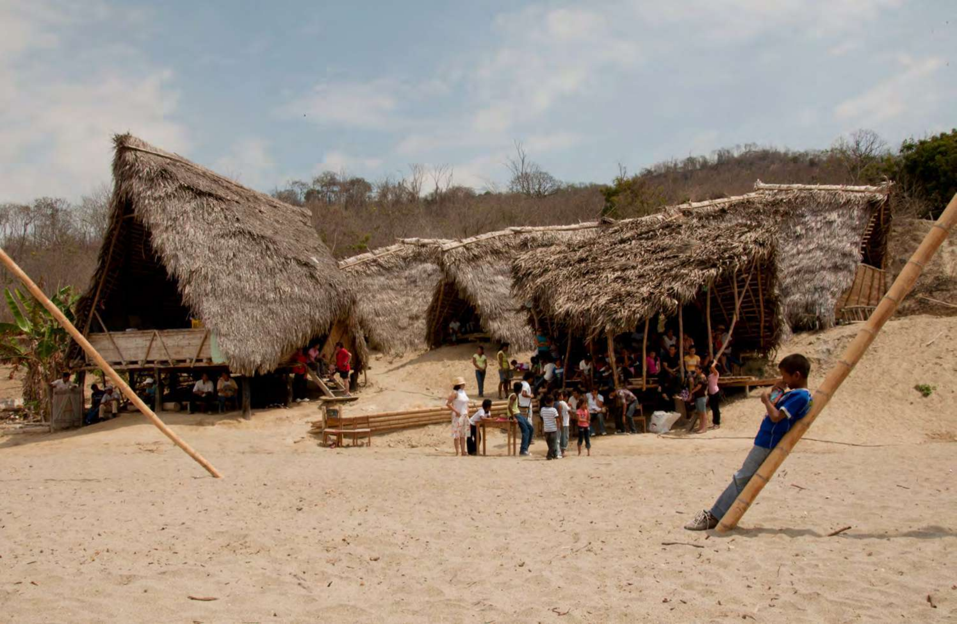
LAS TRES ESPERANZAS - ÉCOLE ET ESPACE MULTIFONCTIONNEL EN ÉQUATEUR Arch. Al Borde
