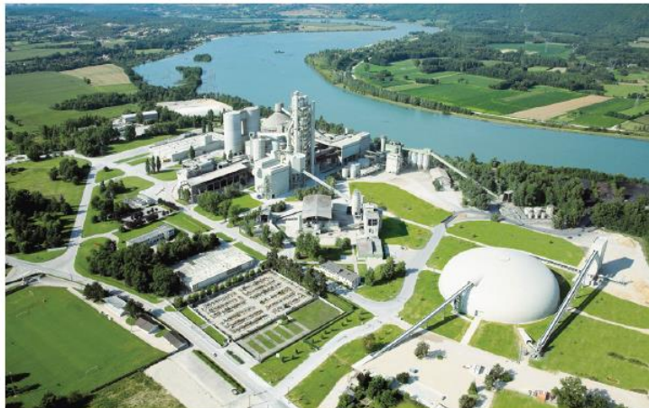
Cimenterie VICAT - Montalieu-Vercieu (Isère)
