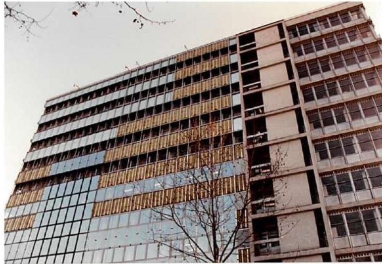
Façades en cours de remplacement en 1993
