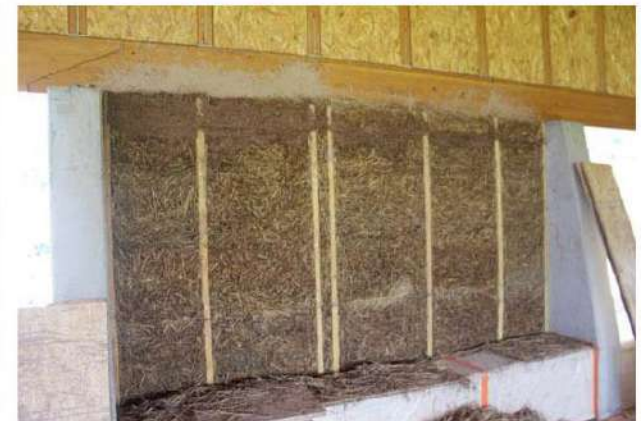
Vue de l'armature bois
