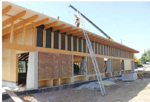
Chantier avant les enduits terre
