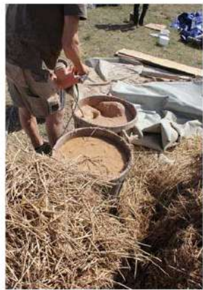
Préparation du mélange terre-paille
