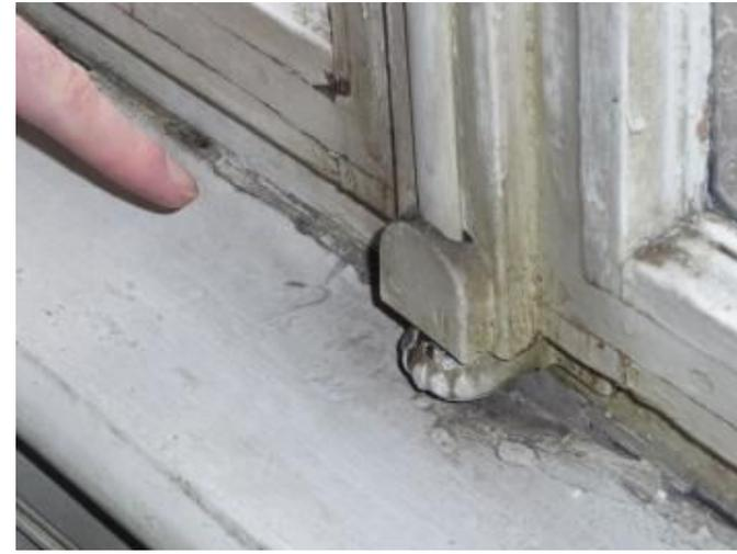
Une perméabilité à l'air très forte ( $Q_4 = 2,5 \text{ m}^3/\text{h.m}^2$  en moyenne sur le panel du projet BATAN)
